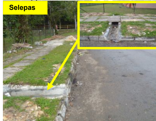
Gambar 1.44 Scupper Drain Telah Dibersihkan
