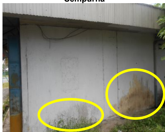
Gambar 4.2 Dinding Yang Tidak Dicat Semula Dengan Sempurna
