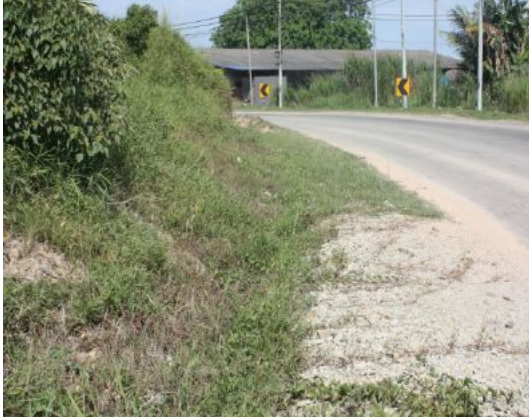
Gambar 1.37 Tanah Menimbus Parit Jalan
