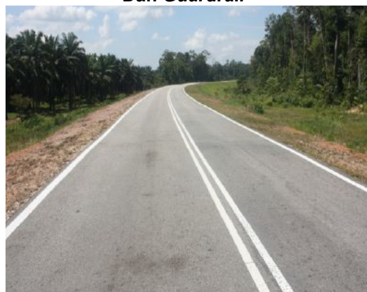
Gambar 1.8 Kawasan Selekoh Tanpa Papan Tanda Dan Guardrail
