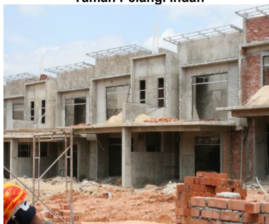
Gambar 5.2 Kerja Pembinaan Di Tapak Projek Taman Pelangi Indah
