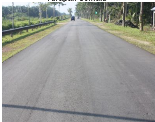
Gambar 1.47 Garisan Jalan Tidak Dibuat Selepas Turapan Semula
