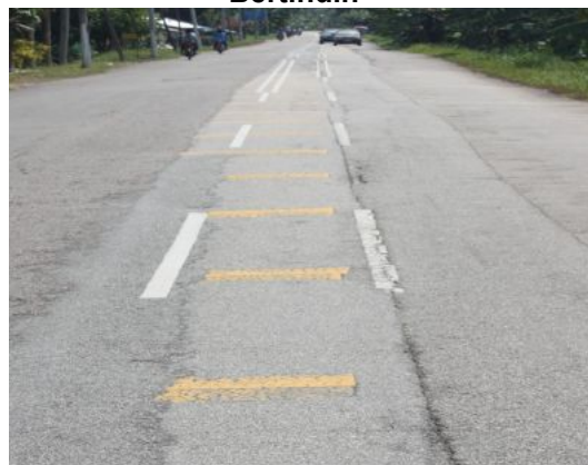
Gambar 1.48 Garisan Jalan Baharu Dan Lama Yang Bertindih
