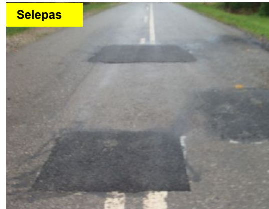
Gambar 1.19 Kerosakan Jalan Telah Dibaiki
