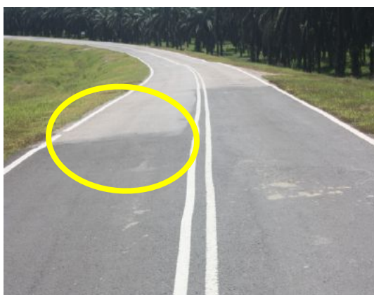
Gambar 1.9 Perbezaan Warna Premix Akibat Daripada 2 Pembekal Berbeza
