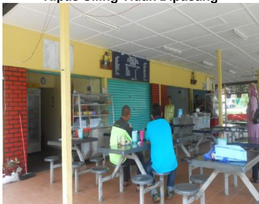
Gambar 4.5 Kipas Siling Tidak Dipasang
