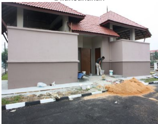
Gambar 3.3 Pembinaan Tandas Awam Yang Sedang Dilaksanakan
