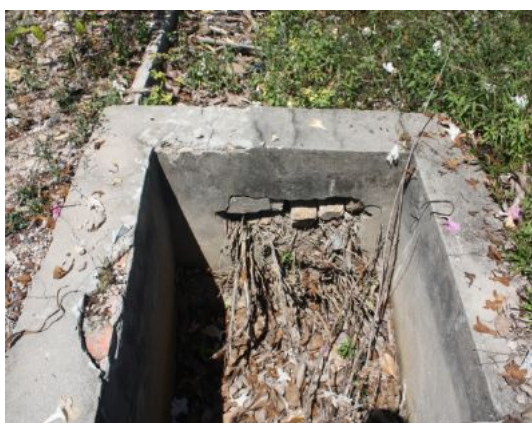
Gambar 1.26 Penyambung Antara Longkang Tidak Dilepa Dengan Simen
