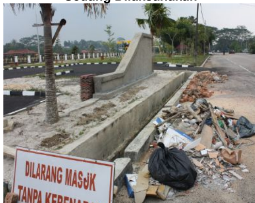
Gambar 3.4 Pembinaan Tempat Letak Kereta Yang Sedang Dilaksanakan
