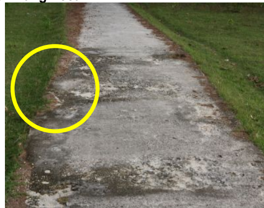
Slab/Jalan Simen Yang Pecah
