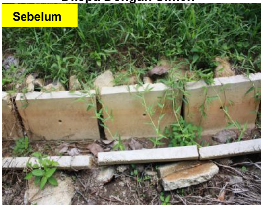
Gambar 1.26 Penyambung Antara Longkang Tidak Dilepa Dengan Simen
