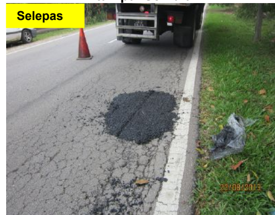
Gambar 1.32 Besi Telah Dipotong Dan Jalan Telah Ditampal Semula
