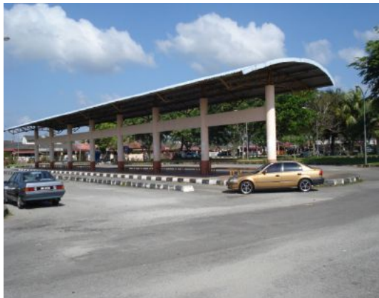
Gambar 3.26 Perhentian Bas Terbiar Tidak Digunakan Selama 8 Tahun
