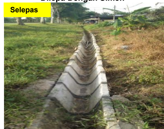
Gambar 1.27 Penyambung Antara Longkang Telah Dilepa Dengan Simen
