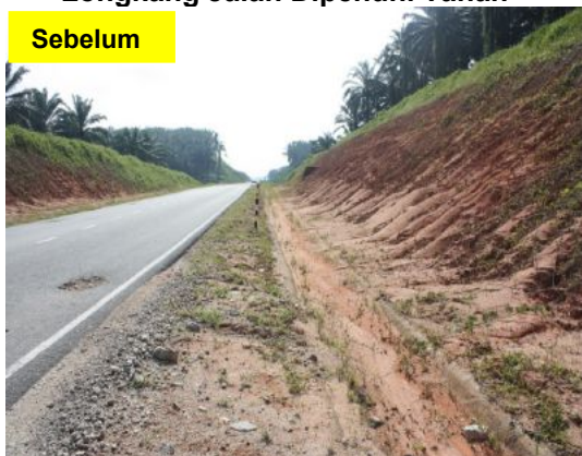
Gambar 1.3 Longkang Jalan Dipenuhi Tanah
