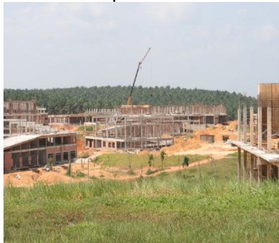
Gambar 5.4 Kerja Pembinaan Di Tapak Projek Kampus Induk YPJ
