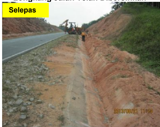
Gambar 1.4 Longkang Jalan Telah Dibersihkan
