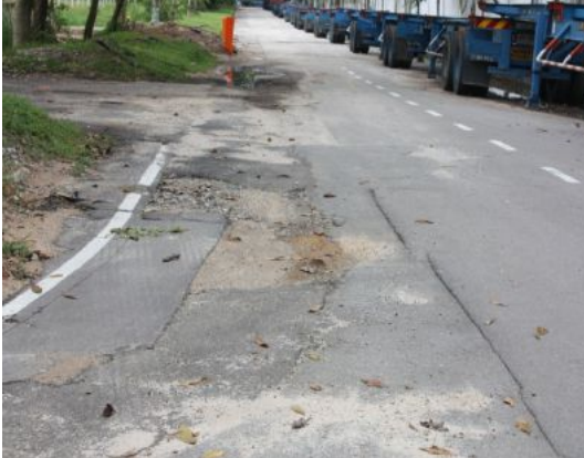
Gambar 1.33 Kerja Tampalan Semula Tidak Kemas
