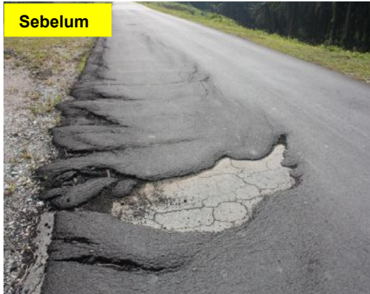
Gambar 1.12 Kerosakan Jalan Jenis Retak Bulan Sabit
