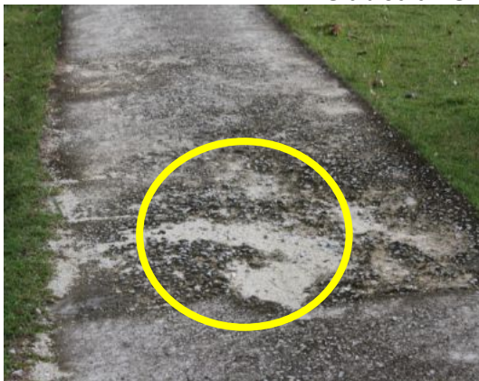
Slab/Jalan Simen Yang Pecah
