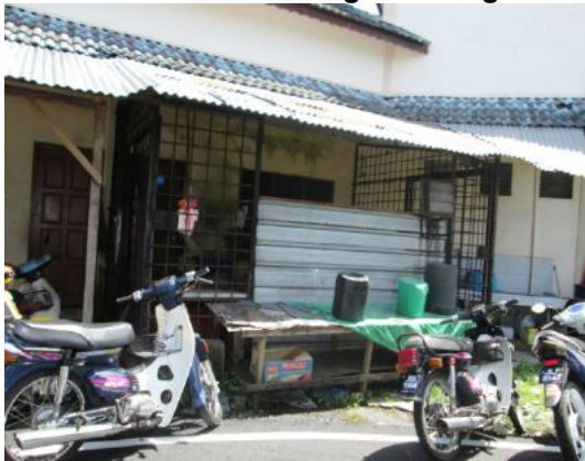
Gambar 4.32 Tambahan Ruang Belakang
